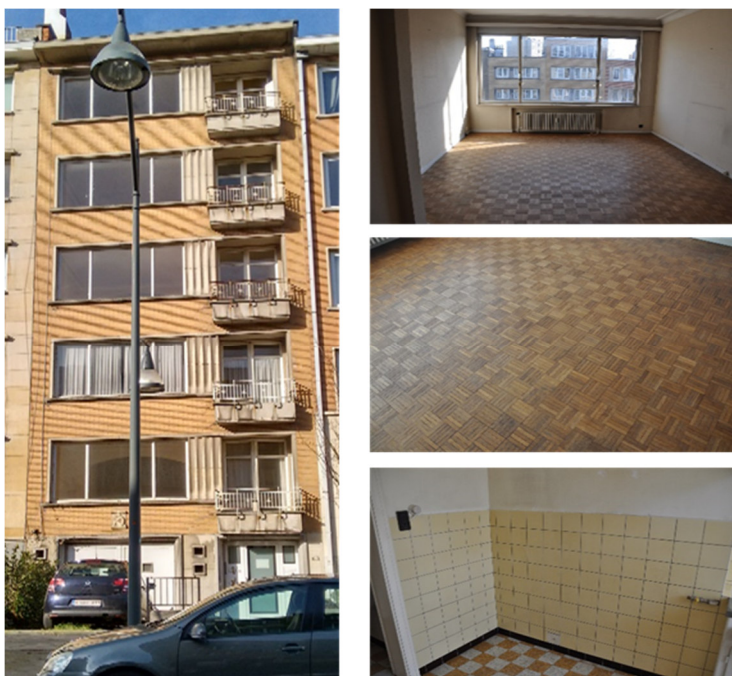
Vue de l'immeuble et de l'intérieur avant rénovation (photos : CSTC)
