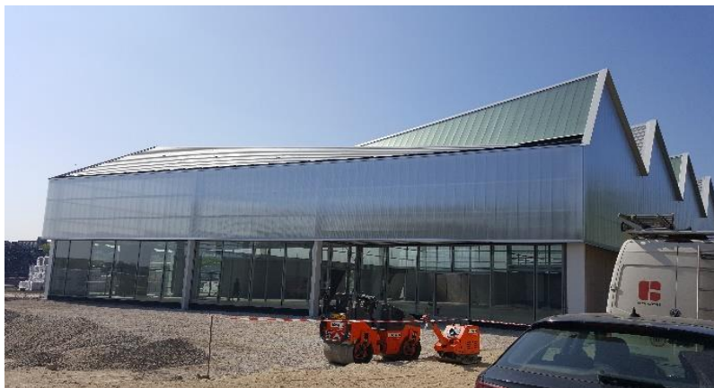
Uitzicht van de bouwplaats eind mei (bron : WTCB)
