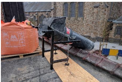
Herbruikbare geverniste pannen en opening van de stortgoot
