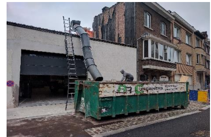
Afvoeren via stortgoot
