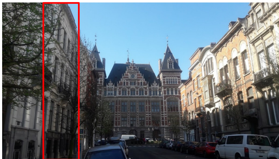
Locatie van het gebouw (bron: Rinoo)
