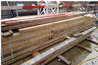
Verpakt hout op de bouwplaats
