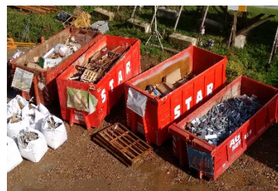
Containerpark op de bouwplaats
