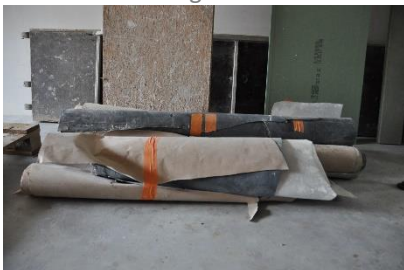
Ingezameld en gesorteerd afval van bitumineuze bedekking
