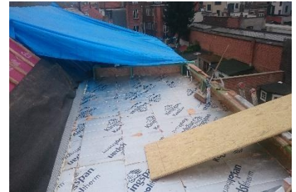
Isolatie hergebruiken op de platte daken
