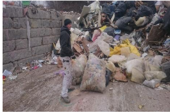
Zakken van Clean Site naar het sorteercentrum brengen
