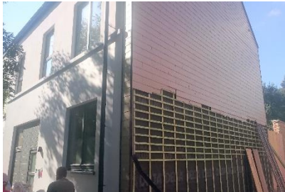
Isolatie op de scheidsmuur
