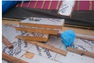
Isolatie hergebruiken op de platte daken
