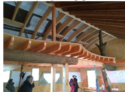
Gebogen dak en boomstammen als bouwelementen (bron plan: AADD Architecture; foto's: WTCB & CBB-H)
