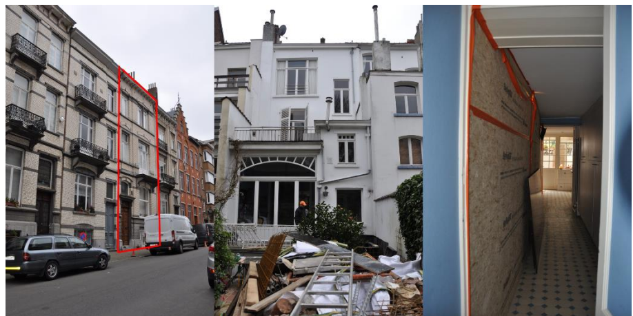
Voor- en achtergevel en bescherming van de gang door het huis (foto's: CBB-H)
