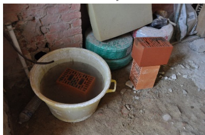
Reiniging en bescherming van metselwerk door indompeling
