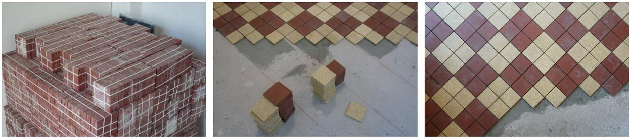
Les carrelages déconstruits puis préparés au réemploi sont finalement réutilisés sur site
