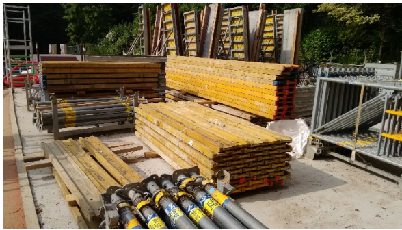
Marquage des lieux de stockage des matériaux selon le modèle LEAN. (photo : CSTC)
