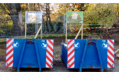
Containers bois et tout-venant (photos : CSTC)
