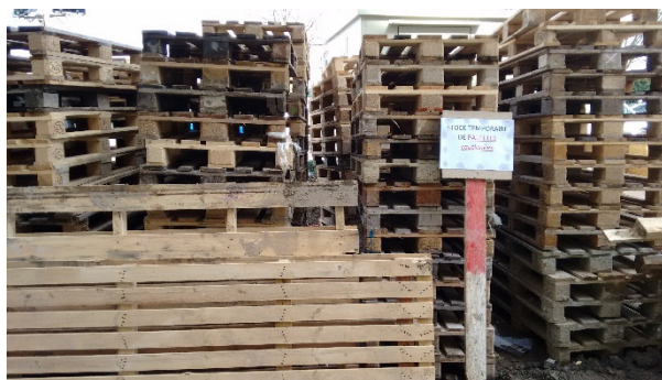
Signalétique et tri des déchets selon le modèle LEAN. (photo : CSTC)
