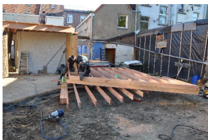
Pré-assemblage des éléments de charpente
