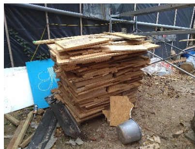
Chutes des panneaux OSB
