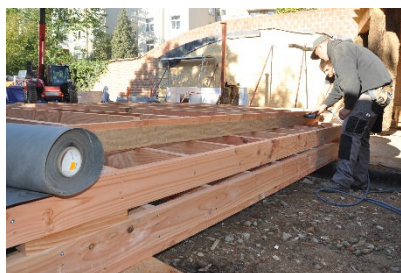
Pré-assemblage des éléments de charpente
