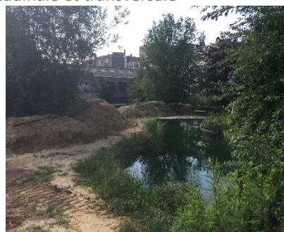
Pièce d'eau et terres excavées
