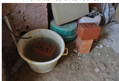
Nettoyage et préservation des maçonneries par trempage
