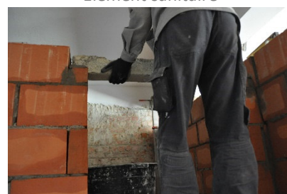
Remise en œuvre des linteaux
