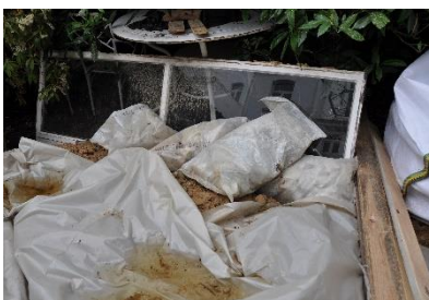
Sacs à gravats de déchets inertes
