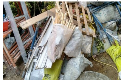
Sacs à gravats de déchets de bois (photos : CCB-C & CSTC)
