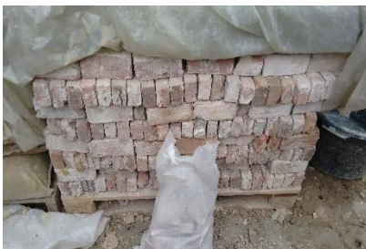
Briques déconstruites et palettisées
