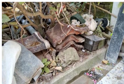
Couvre-mur en tuile vernissée
