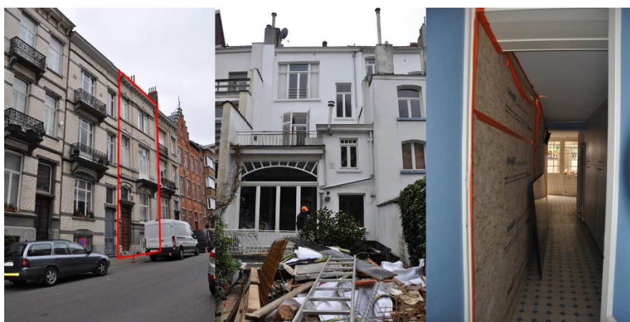
Façades avant et arrière et protection du couloir de circulation à travers la maison (photos : CCB-C)
